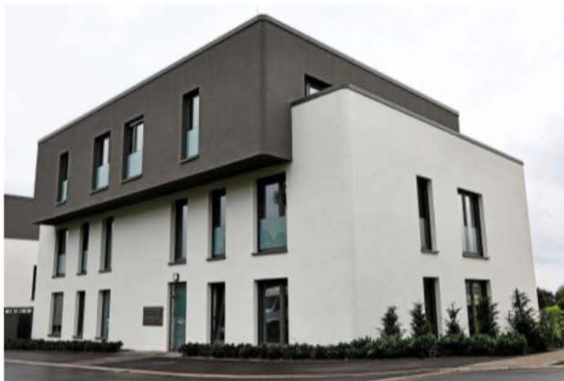
In Leinefelde in der Mühlhäuser Chaussee können sich die Besucherinnen und Besucher in Mehrfamilienhäusern umsehen.
